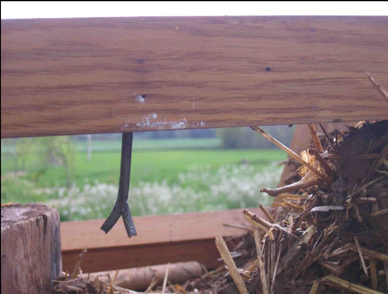
7. Detalle del anclaje
